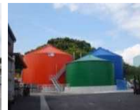
メタン発酵槽・消化液槽
