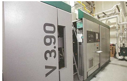
ペレットを不完全燃焼させガス化
